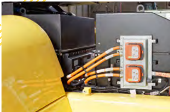
Tehokas ja turvallinen korkeajännitekaapelointi.
